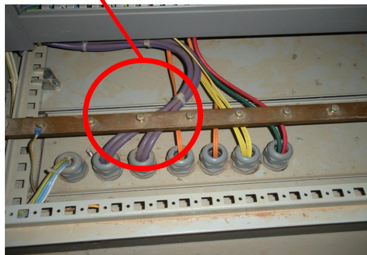
Terminação desabilitada na última caixa de derivação
