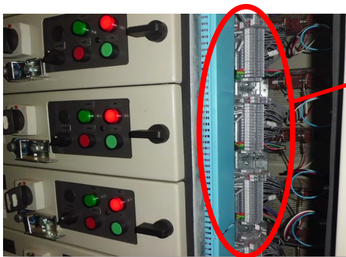
CCM - Gavetas extraíveis com conexões por bornes
